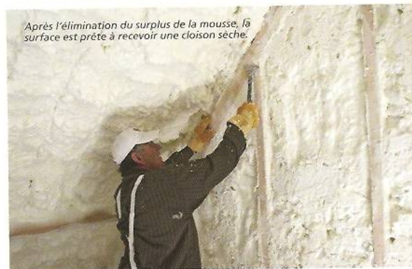
L'isolation de cette maison de 230 m 3 a demandé environ 1000 l de préparation et le coût au m 2 s'élève à 18 euros.
